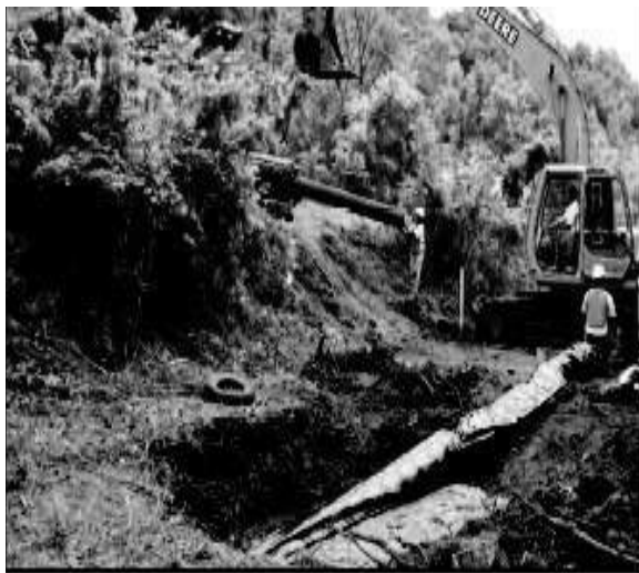
Рисунок 6.24 Картриджный метод укладки труб.
