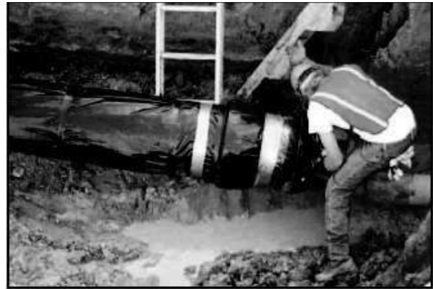
Рисунок 6.22 Покрытие труб полиэтиленовым рукавом.
