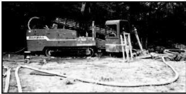
Рисунок 6.17 Прокладка трубопровода методом горизонтально направленного бурения.
