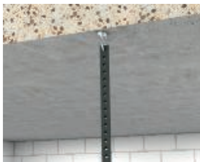
Установка с помощью монтажной ленты Перфорированную монтажную ленту можно крепить к потолку различными способами. Прямой подвес с помощью потолочного крючка TS 2989, который крепится с помощью резьбы M6.
