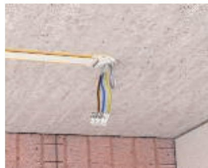
Применение клея Imtri-Fix Клеем Imtri-Fix можно крепить плоские провода. Клей наносится кистью с обеих сторон и провод наклеивается после подсыхания клея. Легкими ударами резинового молотка зафиксировать плоский провод.
