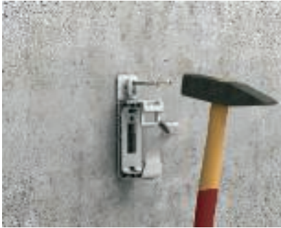
Крепление с помощью забивных дюбелей Забивной дюбель вместе с крепежным элементом вставить в отверстие и забить молотком.
