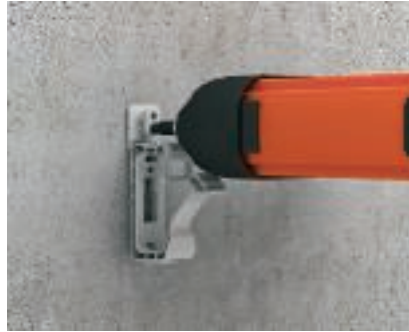
Монтаж с пневмомолотком на стене Крепежный элемент группового крепления-захвата можно надеть на головку пневмомолотка и автоматически зафиксировать с помощью специальных пластин. Крепление выполняется без других вспомогательных средств непосредственно с помощью пневмомолотка к стене или потолку.
