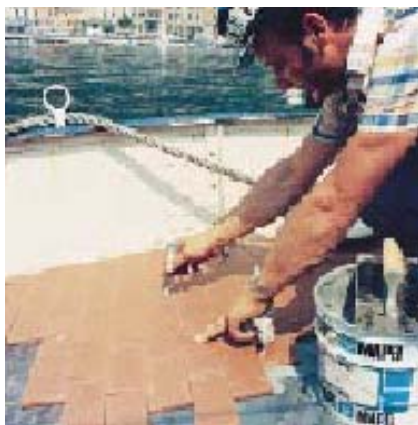
Облицовка металлического основания
