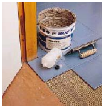
Облицовка по старому покрытию ПВХ
