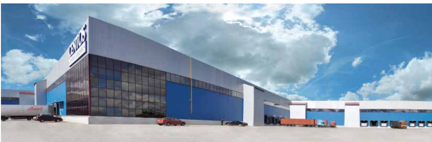
Промышленное складское помещение в Дорохово
