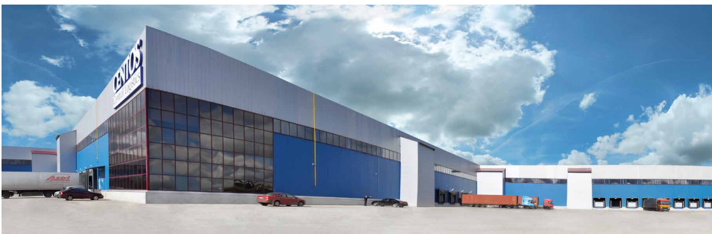
Промышленное складское помещение в Дорохово
