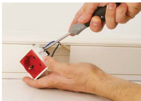
Подсоедините провода к розетке
