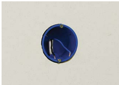
Установите коробку в отверстие в стене
