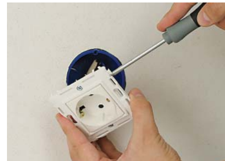
Подсоедините провода к розетке
