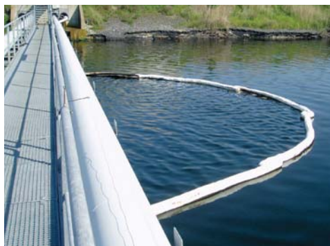
Несколько бонов формируют барьер, окружающий и контролирующий разлив.
