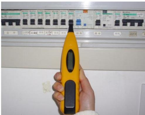
Включите приемник и поднесите его к автомату защиты или предохранителю так, как показано на рисунке слева. В данном примере автоматы расположены вертикально. Если автоматы будут расположены горизонтально, приемник также нужно повернуть на 90 градусов вокруг оси.
