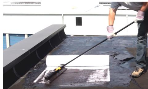
Подготовка поверхности влияет на качество нанесения покрытия и его долговечность.
