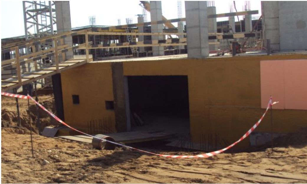
Рисунок 5 - Готовая гидроизоляция фундамента
