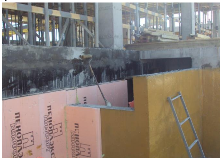
Рисунок 4 - Нанесение пропитки «POLYCOVER-PRO-Primer» валиком
