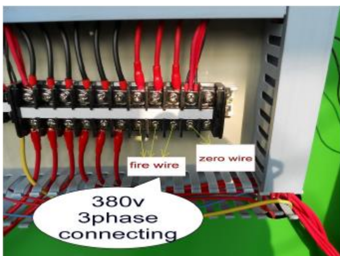
380 В трехфазное соединение
