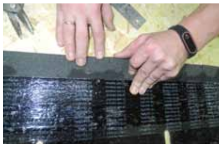
Рис. 5. Насечка для облегчения монтажа
