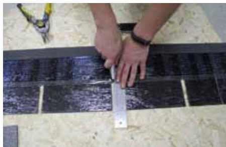
Рис. 6. Деление плитки на лепестки
