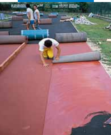
Укладка резиновых напольных покрытий на клей Adesilex G19
