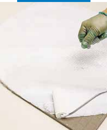
Укладка армированной сетки на тыльную сторону керамической плитки
