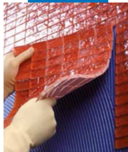
Укладка стеклянной мозаики с помощью Keraroxu Design на стены
