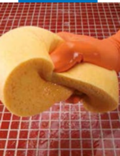
Смачивание поверхности перед очисткой
