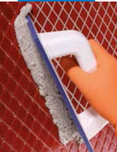
Нанесение Kerapoxy Design плоским резиновым шпателем
