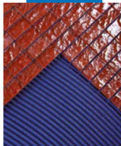
На следующий день, заполнение швов Keraroxu Design того же цвета, с соблюдением выше указанной процедуры заполнения швов
