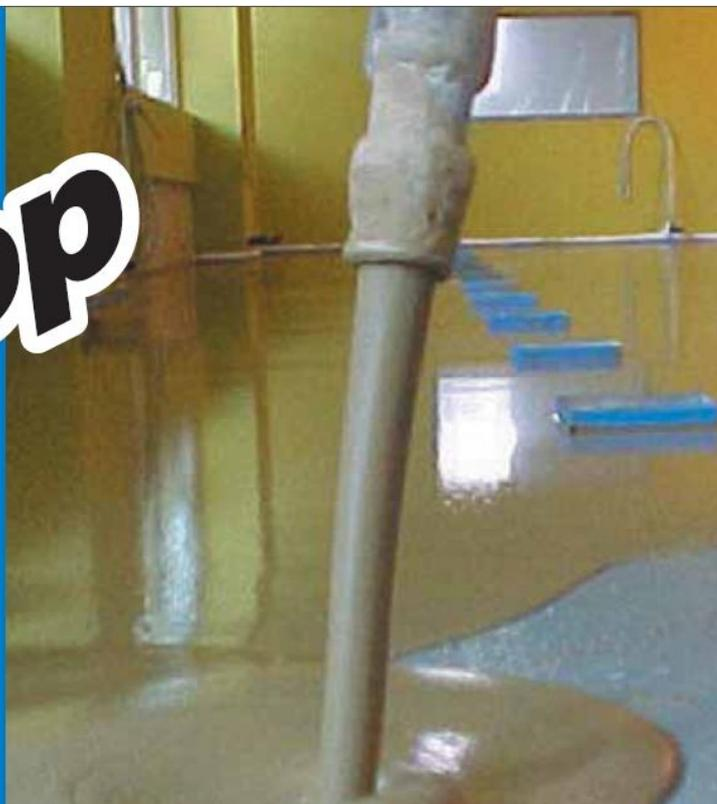
**Быстрохватывающийся самовыравнивающийся состав на основе специальных гидравлических вяжущих для производства износостойких полов толщиной от 5 до 40 мм.**
