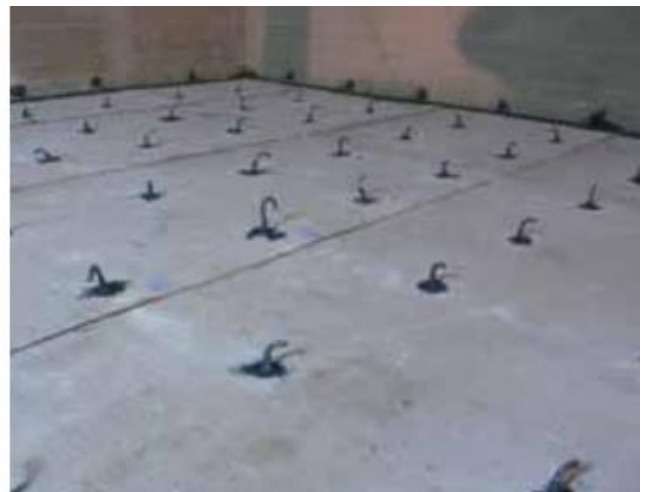
Рис. 4 – Заделка соединительных стержней Mapeproof Mastic
