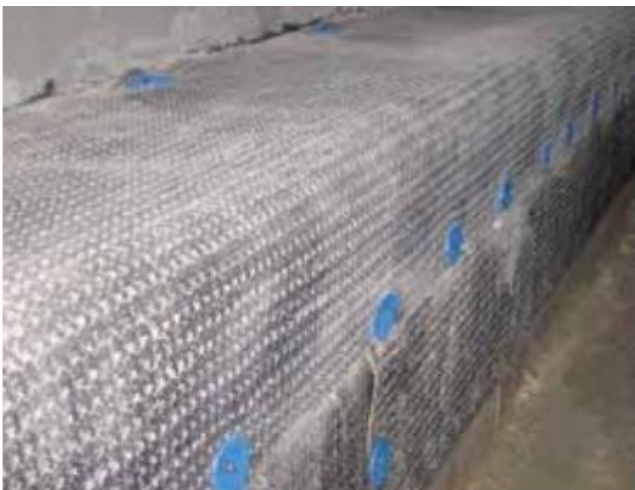
Рис. 5 – Герметизация между бентонитовыми листами Mapeproof и Mapeelastic Foundation с помощью Mapeproof Mastic
