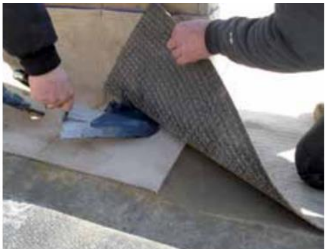
Рис. 6 – Герметизация стыков бентонитовых листов Mapeproof с помощью Mapeproof Mastic
