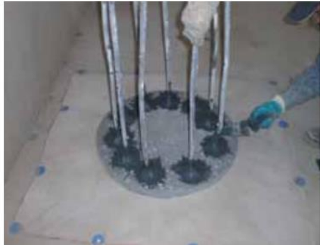
Рис. 2 – Нанесение Mapeproof Mastic вокруг арматурных стержней в оголовках свай
