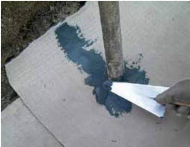
Рис. 1 – Нанесение Mapeproof Mastic шпателем вокруг трубы
