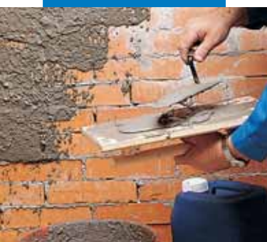
Связующий штукатурный слой с добавлением Planicrete
