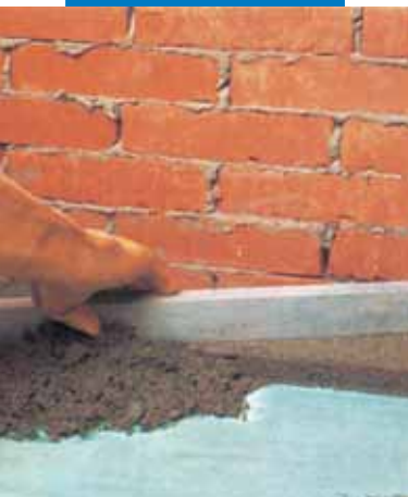
Укладка цементной стяжки с добавлением Planicrete
