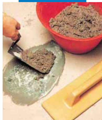
Ремонт пола: нанесение строительного раствора
