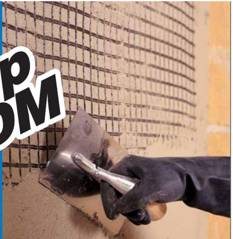
**Двухкомпонентный, высокоэластичный, пуццолановый цементный состав, используемый в «системе» с сеткой Mapegrid G220 для структурного усиления кладки и для выравнивания поверхностей в бетоне, камня, кирпичной и каменной кладки.**
