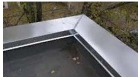
МОНТАЖ НАКРЫВОК НА ПАРАПЕТ
