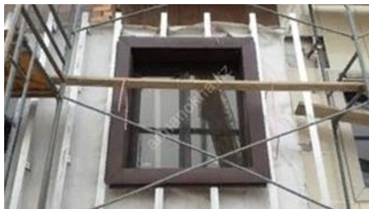
МОНТАЖ ОКОННЫХ ОБРАМЛЕНИЙ
