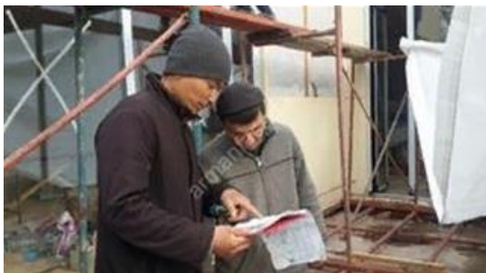
МОНТАЖ ФАСАДНЫХ КАССЕТ С КАРКАСОМ
