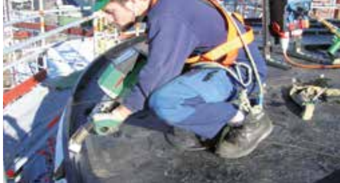
Наружное использование WELDPLAST S4 в Испании.
