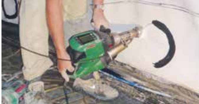
Мощный WELDPLAST S2 наваривает заплатку в тоннеле.
