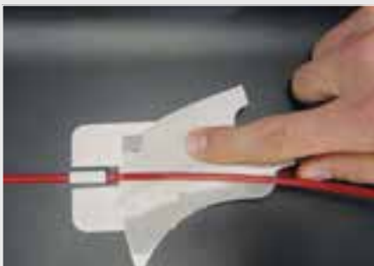
Шаг 3: Снятие избытка сварочного прутка при помощи триммера и Спатула-ножа
