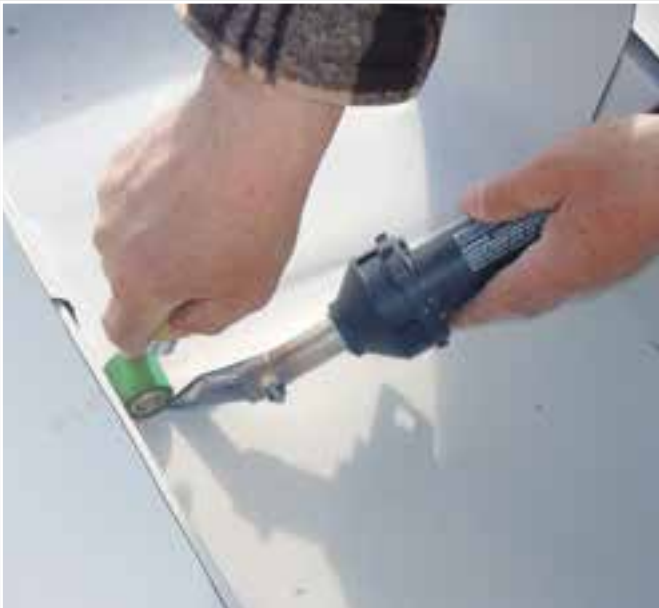
Hot-Jet S идеально подходит для работы с мелкими деталями на крыше.
