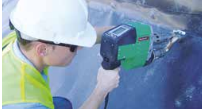
Мощный WELDPLAST S4 в работе.
