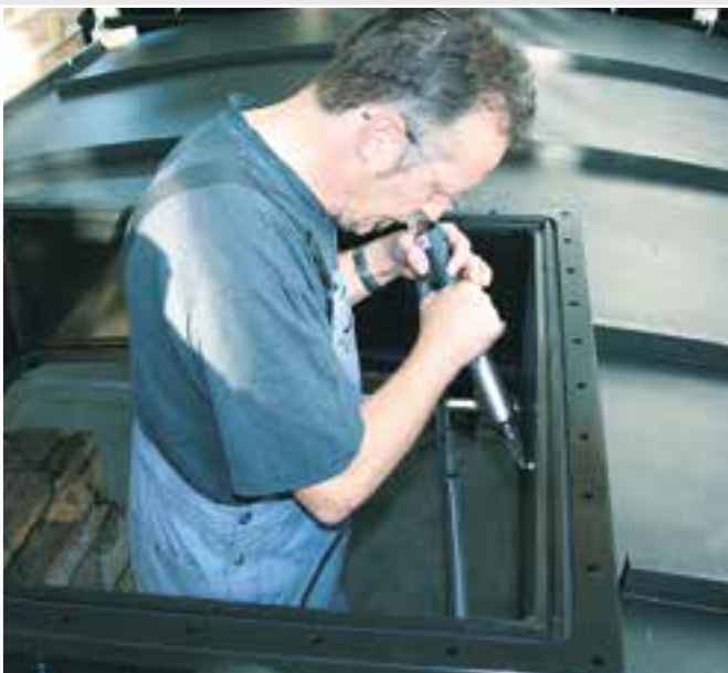
DIODE S применяется для сварки прутком деталей резервуара.
