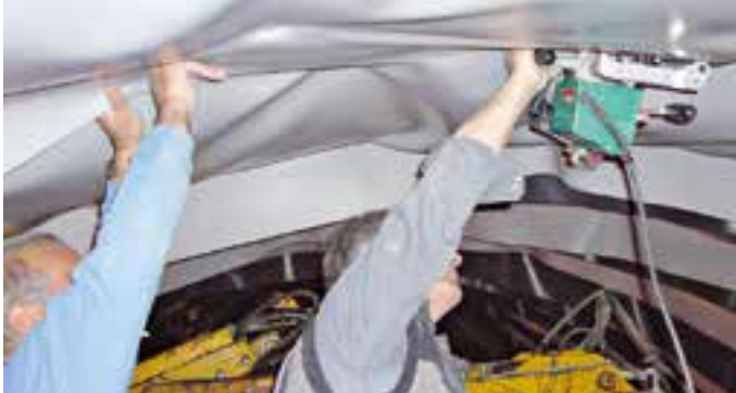
Comet при работе в тоннеле...
