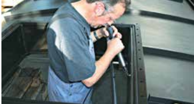
Контурная сварка ПЭ контейнера с помощью DIODE PID.
