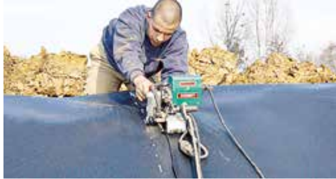
... или на площадке строительства полигона.
