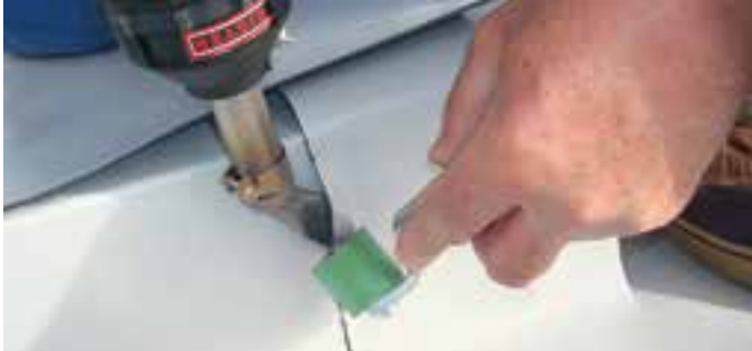
HOT JET S с угловой насадкой при сварке Т-образного соединения на крыше.
