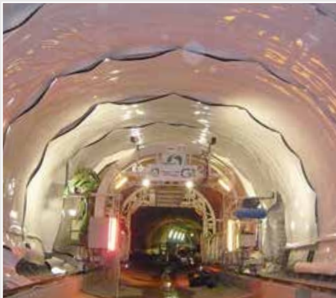
Тоннель из ПВХ 2.5 мм
