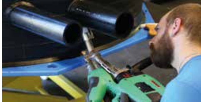
Сварка под углом 45 ° и 90 ° с помощью новых угловых насадок
