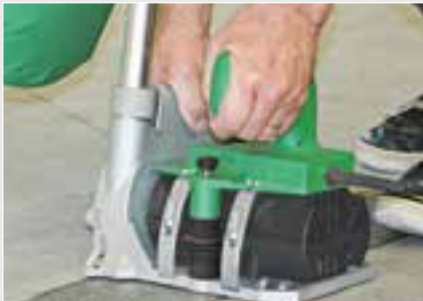
Шаг 1: Фрезерование канавки с помощью GROOVER
