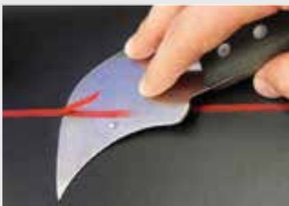
Шаг 4: Выравнивание выступающего сварочного прутка при помощи Спатула-ножа
