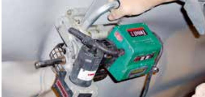
TWINNY T, с практичной поперечной рукояткой во время сварки под потолком в тоннеле
