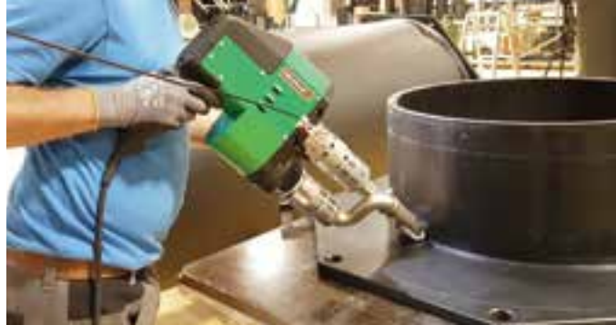
Мощный WELDPLAST S4 в работе.
