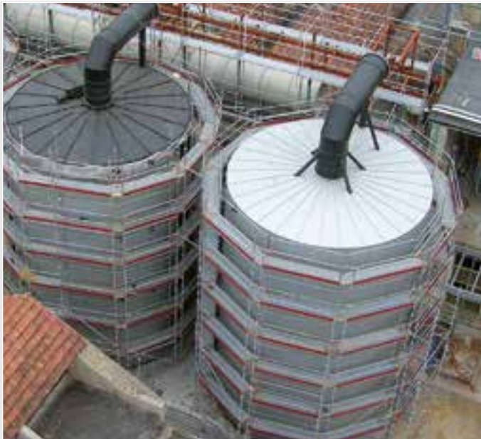
Системы очистки воздуха, Испания. Материал: ПЭНД
