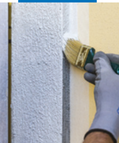
Защитное покрытие карниза окна с помощью Mape-Antique Ecolastic
