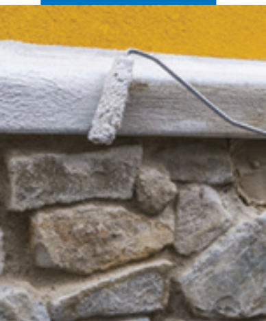
Гидроизоляция стен с помощью Mape-Antique Ecolastic
