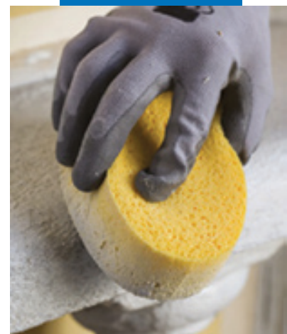
Полировка Mare-Antique Ecolastic с помощью губки
