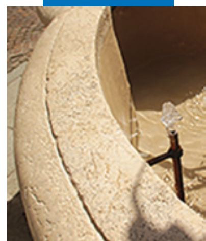
Герметизация каменной чаши фонтана
