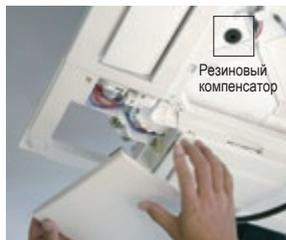
Снимите угловую крышку панели.
