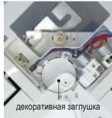
Снимите декоративную заглушку и проверьте состояние дренажного поддона. Если требуется чистка, то вначале снимите резиновую пробку, чтобы слить воду, а затем дренажную крышку (пробку).
