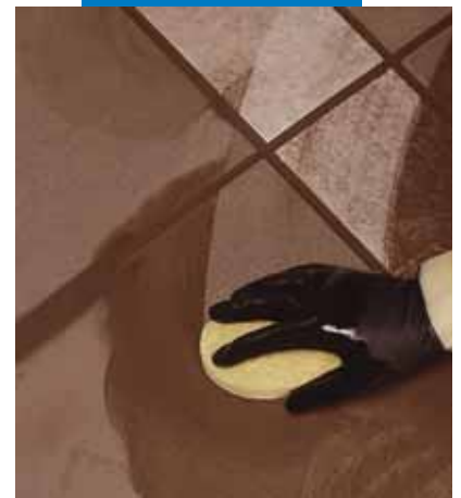
Окончательная очистка плитки губкой
