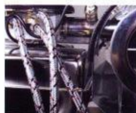
Топливный бак и трубопроводы
