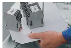
Монтаж устройств на монтажную плату
