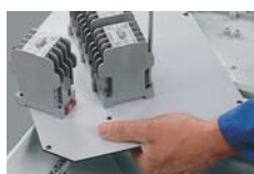
Монтаж устройств на монтажную плату
