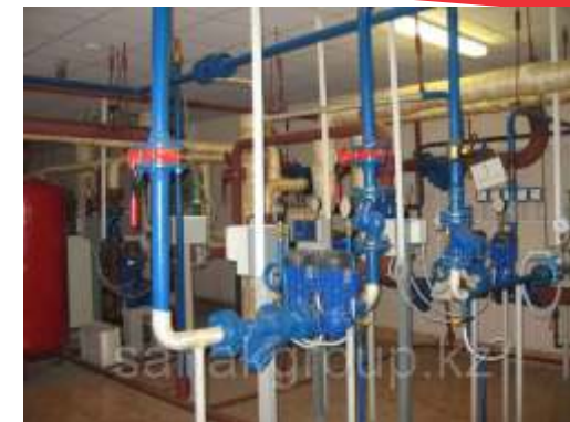
Составление акта обследования водопроводной сети на водоотдачу
