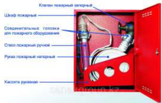
Проверка работоспособности внутреннего пожарного водопровода
