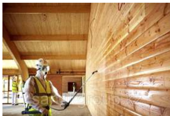
Огнезащитная обработка
