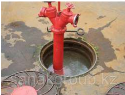
Составление актов обследования пожарных гидрантов
