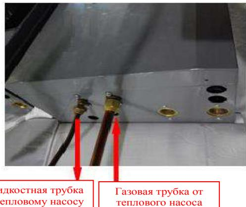
2. Протрите быстроразъемные соединения чистой тканью, чтобы предотвратить попадание пыли и примесей в трубы.
