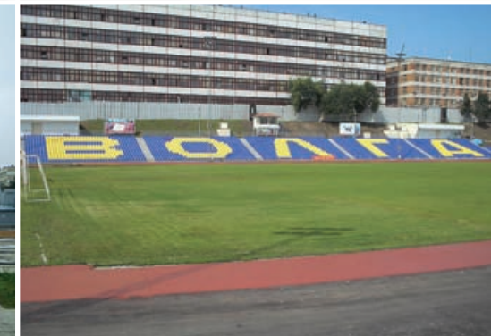
г. Ульяновск Центральный стадион «Труд»
