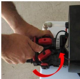
Рисунок 4: Блокировочные краны – настройка позиции перепускного клапана
