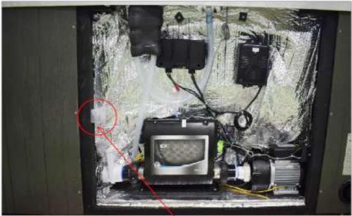
Расположение дополнительного предохранителя
