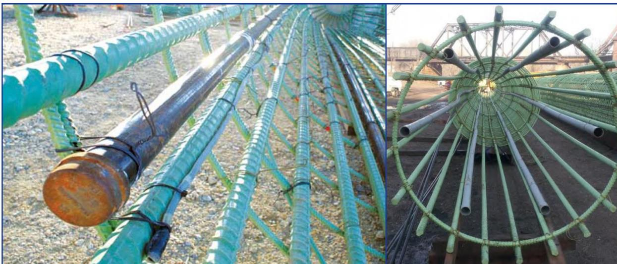
Рисунок 2 – Расположение теплотметрических трубы на арматурном каркасе сваи.
