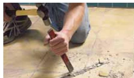
Также сделайте штробу в полу для прокладки соединительного провода.
