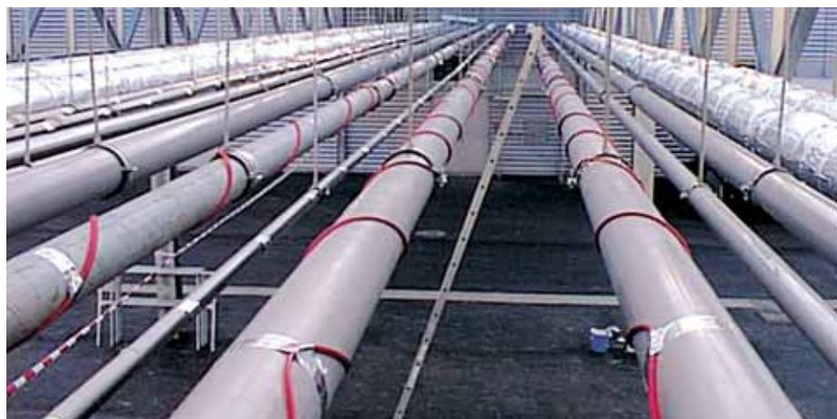
Системы защиты от замерзания устанавливаются на объектах, где необходимо предотвратить замерзание и повреждение льдом водопроводных или канализационных труб.
