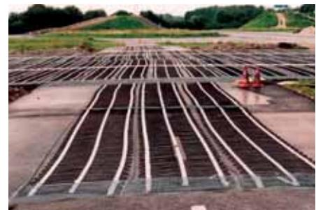
ратуру 240 °C. Этот тип кабеля не обязательно покрывать защитным слоем, что позволяет сэкономить время и затраты на установку. При укладке асфальта желательно не использовать тяжелое оборудование, чтобы не повредить кабель.
