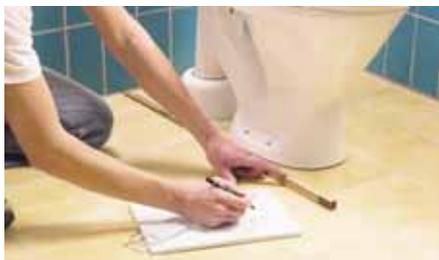
2. Сделайте штробу в полу для гофротрубы датчика температуры на 30-50 см в зону нагрева. Установите гофротрубу с датчиком и заклейте ее конец. См. также р. 8.3.
