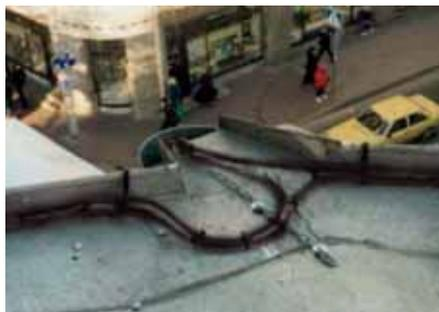
альных металлических зажимов. Задача этого крепления также развести две линии кабеля друг от друга, чтобы отсутствовало касание линий кабеля и соответственно его перегрев.
