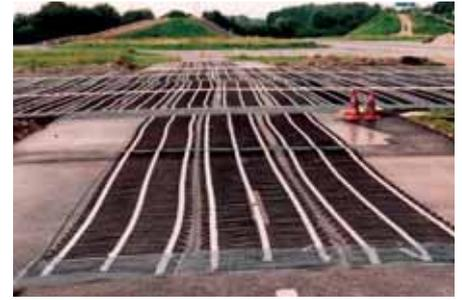
ратуру 240 °С. Этот тип кабеля не обязательно покрывать защитным слоем, что позволяет сэкономить время и затраты на установку. При укладке асфальта желательно не использовать тяжелое оборудование, чтобы не повредить кабель.
