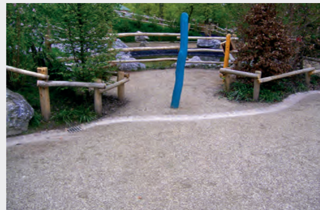
Готовое водосвязное покрытие в качестве системы укрепления дорожек, всепогодный зоопарк в Мюнстере
