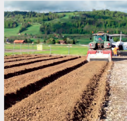
Внесение песчано-щебеночной смеси в верхний слой почвы в соотношении 60:40 путем боронования
