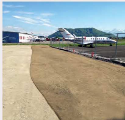
Насыпка и выравнивание балластного слоя (смесь почвы и мелкого щебня)
