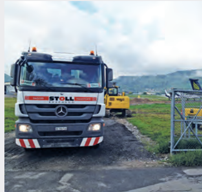
Снятие дерна; насыпка щебня для несущего слоя
