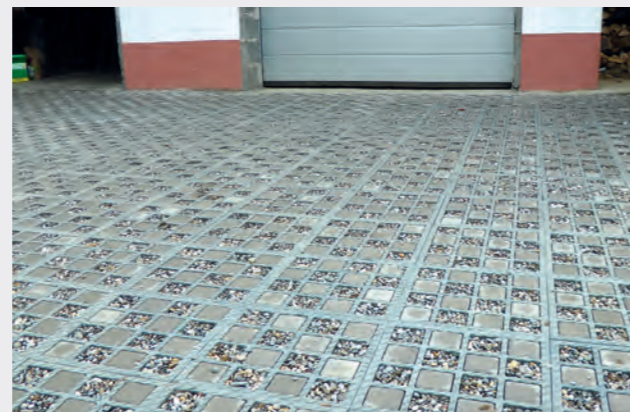
Покрытие TTE® с брусчаткой и гравием: всегда ровное и водопроницаемое
