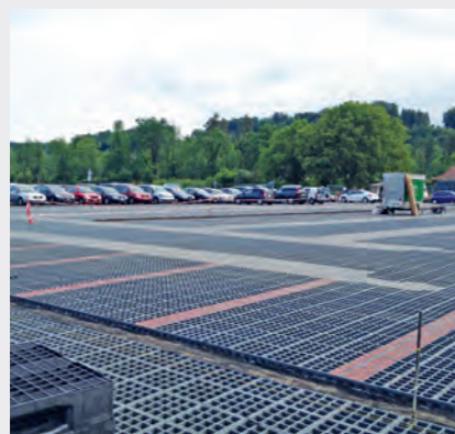
Брусчатка ТТЕ® в качестве элементов разметки парковочных мест и пешеходных дорожек
