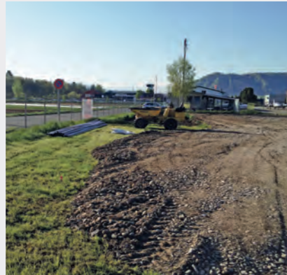
Насыпка песчано-щебеночной смеси непосредственно на имеющийся верхний слой почвы с последующим выравниванием
