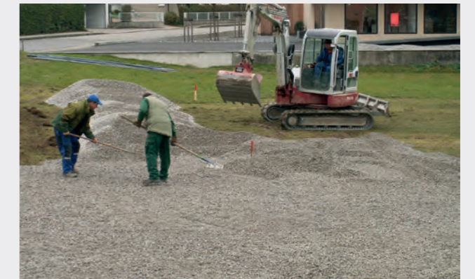
2. Нанесение и выравнивание минерального структурного материала
