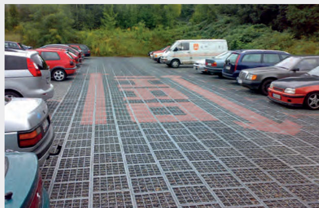
Парковка фирмы Hans Ihro GmbH с логотпом из брусчатки TTE® (элементы заподлицо заполнены щебнем).
