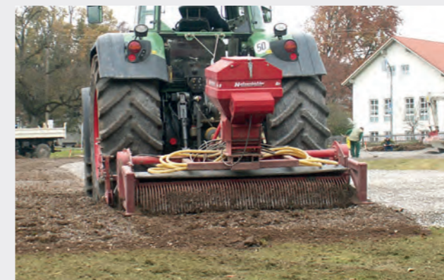
3. Смешивание компонентов путем боронования (60 % об. щебня и 40 % об. имеющейся почвы)
