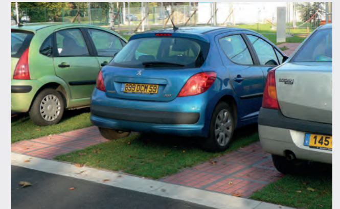
Расширенные маркировочные полосы одновременно служат прочными и проезжими в любую погоду колеями для въезда на парковочное место и выезда с него.
