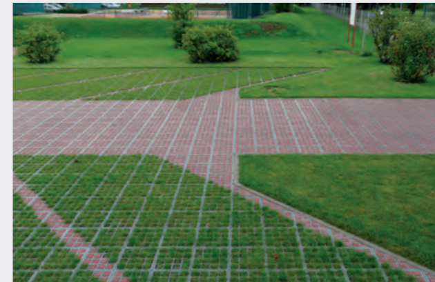
Проезды и парковочные места легко и просто обозначаются брусчаткой ТТЕ®. Растровая структура поверхности позволяет без проблем реализовать самое разное оформление площадки.
