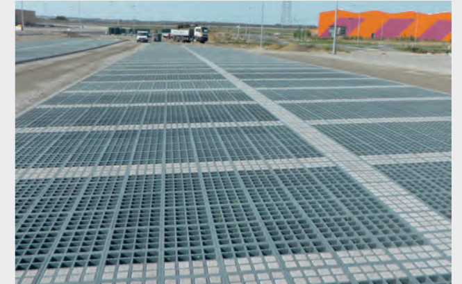
Сквозные двойные ряды парковочных мест визуально разделены полосами брусчатки на торцах (снимок сделан на стадии строительства).
