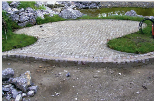
Уложенные и заполненные элементы TTE® перед нанесением водосвязного покрытия.
