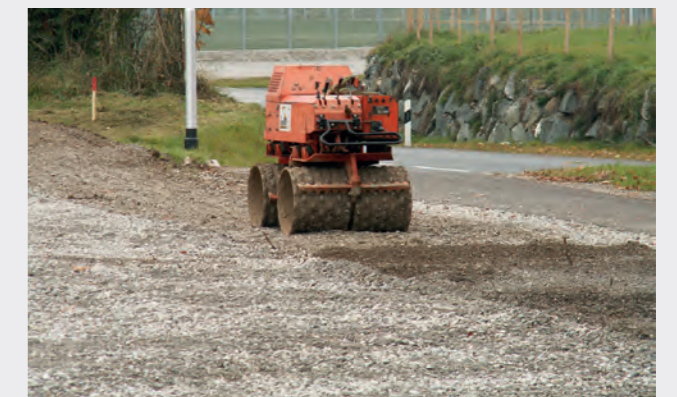
4. Уплотнение и окончательная планировка поверхности
