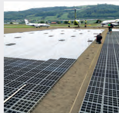
Укладка элементов на мелкоячеистую сетку, служащую вспомогательным средством и разделителем
