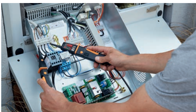
Измерение напряжения на компрессоре
