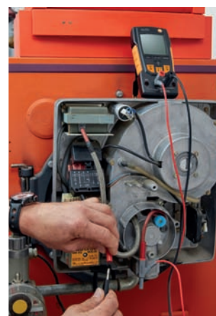
Подготовка к измерению ионизационного тока
