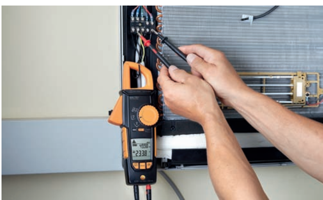
Измерение напряжения на блоке кондиционера с testo 770
