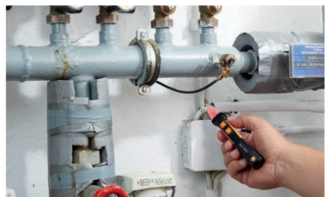
Проверка питания в распределительном щитке с testo 745
