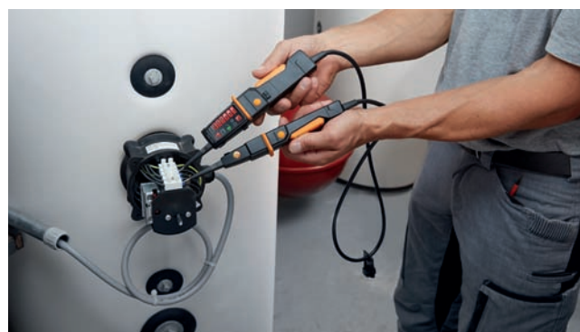
Измерение напряжения на бойлере
