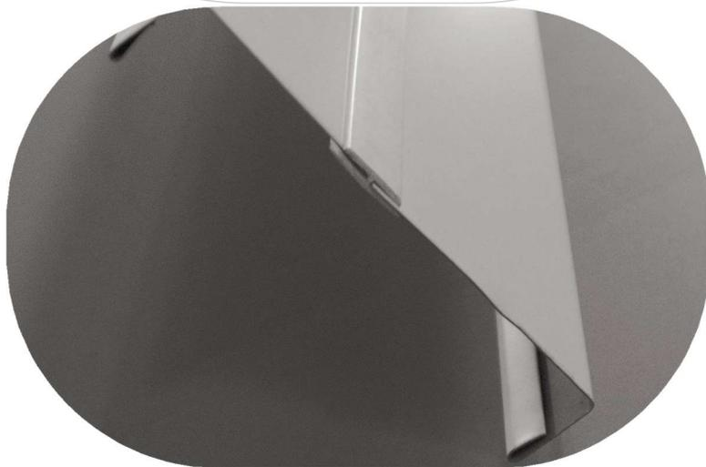
При монтаже сэндвич-панелей на пол необходимо учитывать сторону панелей, лицевой стороной вверх. Лицевая сторона промаркирована на панелях. Панели для пола и потолок должны точно соответствовать одному из поперечных размеров камеры (внешнему или внутреннему) либо по длине, либо по ширине. Вариант укладки указывается на сборочном чертеже. Вертикальные углы камеры заделывают металлическими уголками, обычно совпадающими по цвету с наружной поверхностью стеновых панелей.
