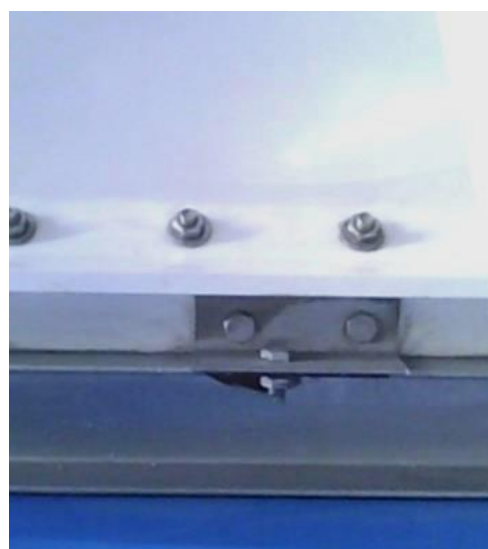
Крепление нижней панели и основания
