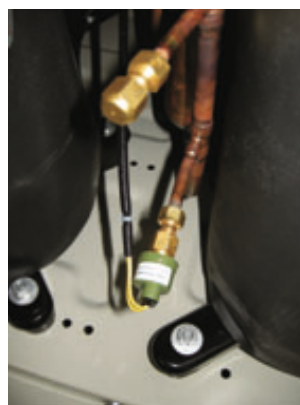
Предохранительные клапаны высокого давления
