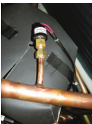
Предохранительный клапан низкого давления
