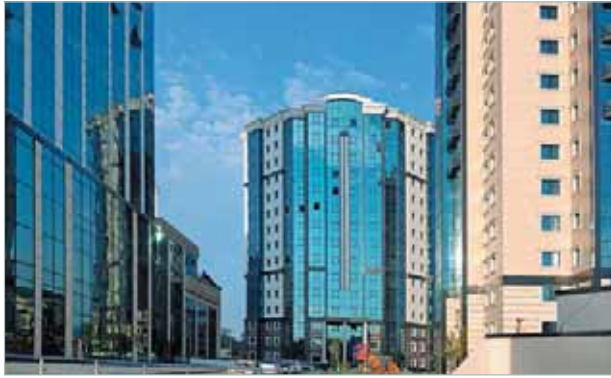
Жилой комплекс «Гудермес Сити» г. Грозный, Чеченская Республика — Мультизональные системы Electrolux
