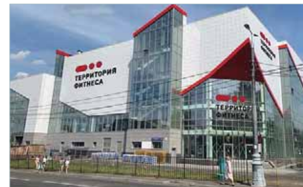
Фитнес-центр «Территория фитнеса» г. Москва – Мультизональные системы Electrolux
