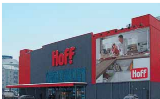
ТЦ HOFF г. Химки — Мультизональные системы Electrolux
