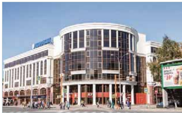
«Газпром» г. Кемерово — Мультизональные системы Electrolux
