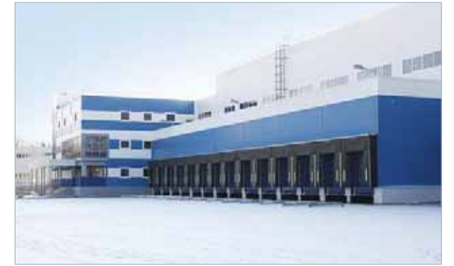
Производственно-складской комплекс Parmalat д. Северово, Московская обл. — Мультизональные системы Electrolux
