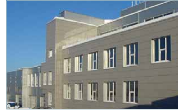
Торгово-производственный комплекс «Беседы» М. О. – Мультизональные системы Electrolux
