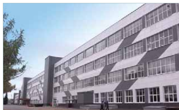
Ижевский Механический Завод г. Ижевск, Удмуртская респ. — Мультизональные системы Electrolux
