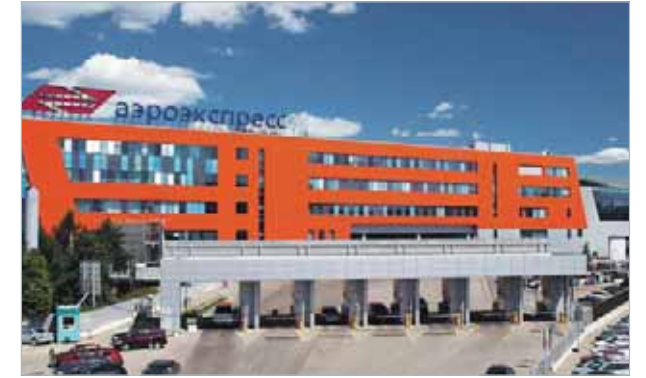
«Аэроэкспресс» г. Химки — Мультизональные системы Electrolux
