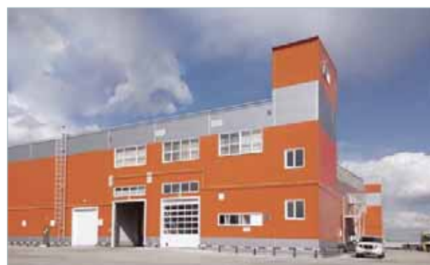
Офисное здание г. Пенза — Мультизональные системы Electrolux
