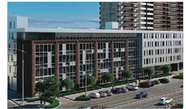
Торгово-офисный центр г. Краснодар – Мультизональные системы Electrolux
