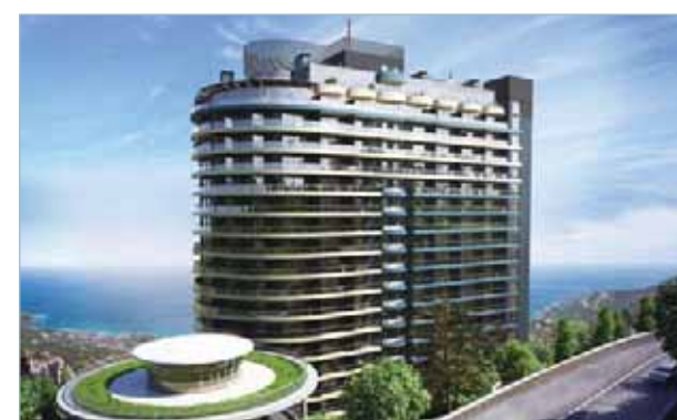
ЖК «Приморский Park House» г. Ялта — Мультизональные системы Electrolux
