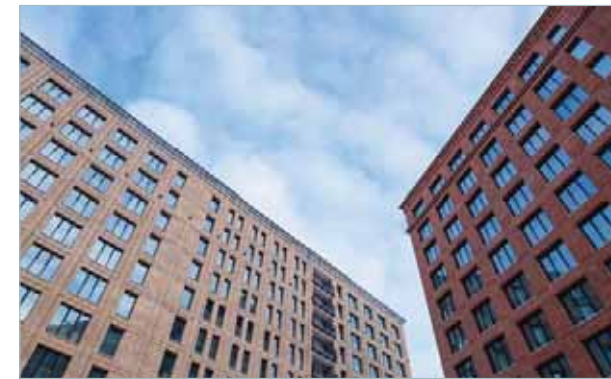
ЖК «Docklands» г. Санкт-Петербург — Канальные блоки Electrolux
