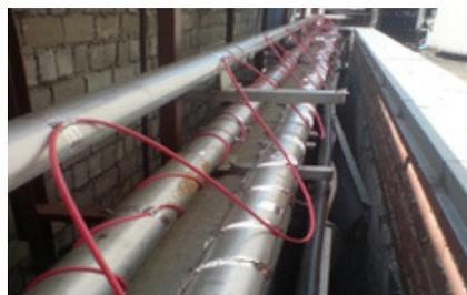
Кабель должен быть равномерно распределен по поверхности, пересечение резистивных кабелей запрещается.
