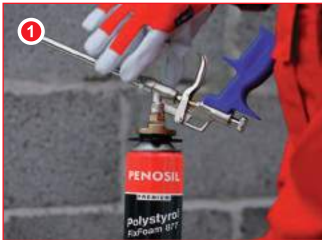
Прикрутить пистолет для пены к баллону!
