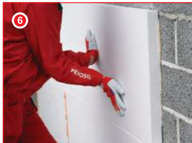
Прижать панель к стене.
