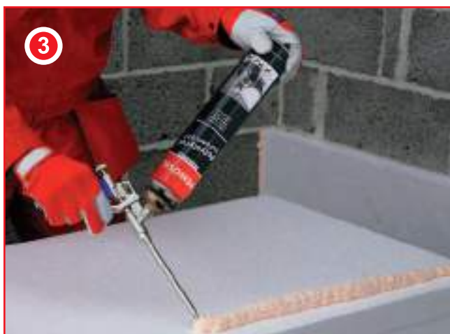
Нанести клеящую пену на изоляционную панель по периметру, отступая по 3-4 см от края.
