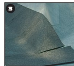
3 Ендовый ковер RUFLEX VIO Сделает все «слабые» места кровли абсолютно герметичными
