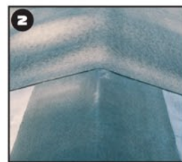
2 Подкладочный ковер RUFLEX Двойная защита кровли от косога дождя и наледей
