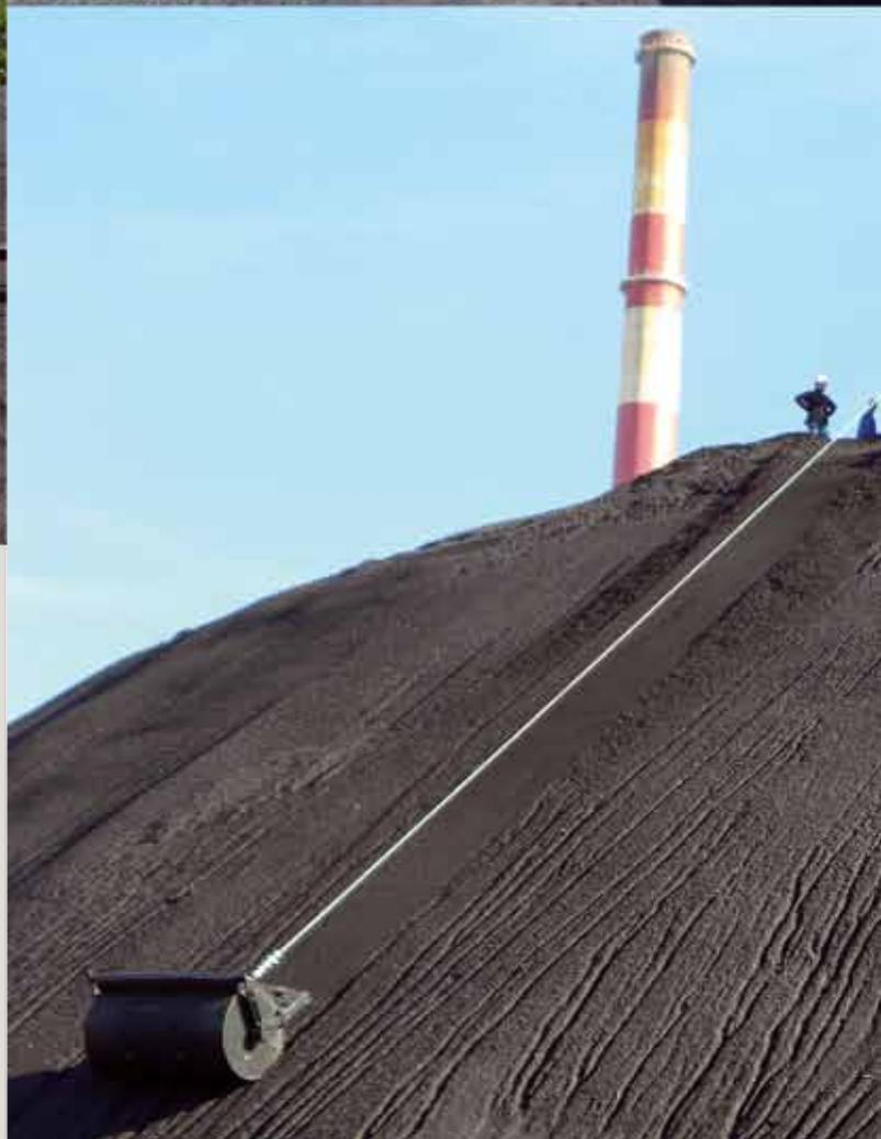
Уплотнение склонов отвалов производится перемещением вверх/вниз стального катка, прикрепленного к лебедке с помощью троса.
