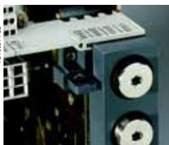
Блокировка вкатывания при открытой дверце
