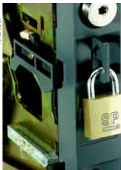
Блокировка в положении «выкачено» навесным замком
