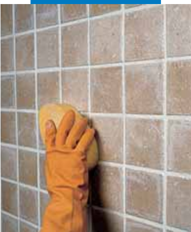
Отделка плитки одинарного обжига губкой
