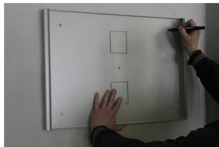
**ИСПОЛЬЗУЕМ ЗАДНЮЮ СТЕНКУ ШКАФА ДЛЯ НАНЕСЕНИЯ МАРКИРОВКИ ПОД ОТВЕРСТИЯ ДЛЯ КРЕПЛЕНИЯ ШКАФА НА СТЕНЕ.**
