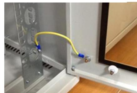
**ПОСЛЕ УСТАНОВКИ ДВЕРИ КРЕПИМ ПРОВОД ЗАЗЕМЛЕНИЯ НА ДВЕРЬ.** Используется гайка M5 – 2 шт. и шайба Ø 5 – 2 шт. Второй конец провода заземления крепится к 19" направляющей винтом-саморезом 3.9 x 9.5 полуцилиндр и шайбой Ø 5.
